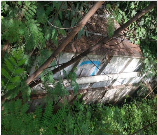
污水处理设施
