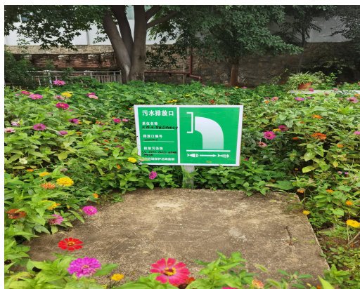
厂区污水总排口
